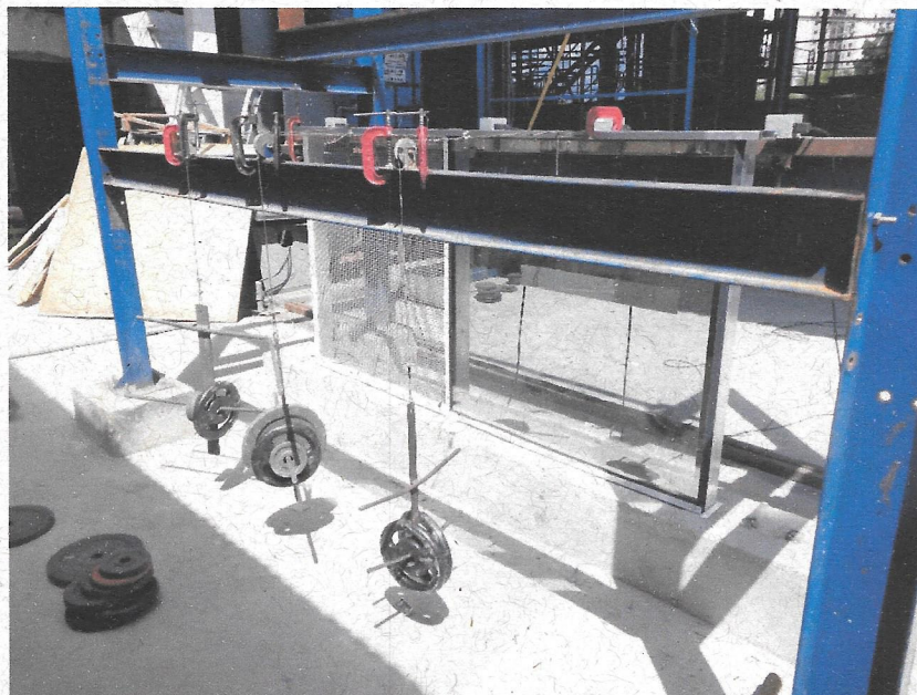
Foto nº. 01 Determinação do esforço estático horizontal (Pré-carga): Posição dos deflectômetros.
