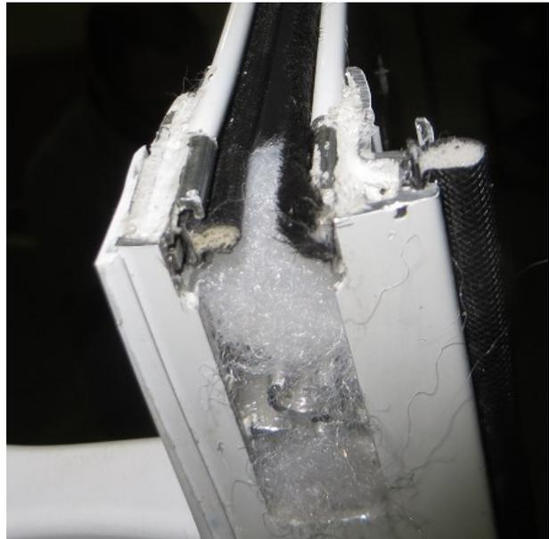
**Foto 2** – Detalhes presentes na travessa superior da folha: tira de espuma coberta com compósito plástico, escova e preenchimento com lã de PET.
