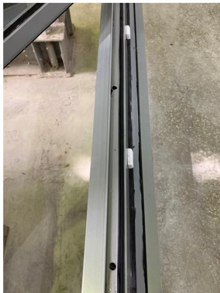
**Foto 10:** Três orifícios para drenagem com diâmetro aproximadas de 10mm na travessa do marco da folha de girar e de tombar com duas saídas.
