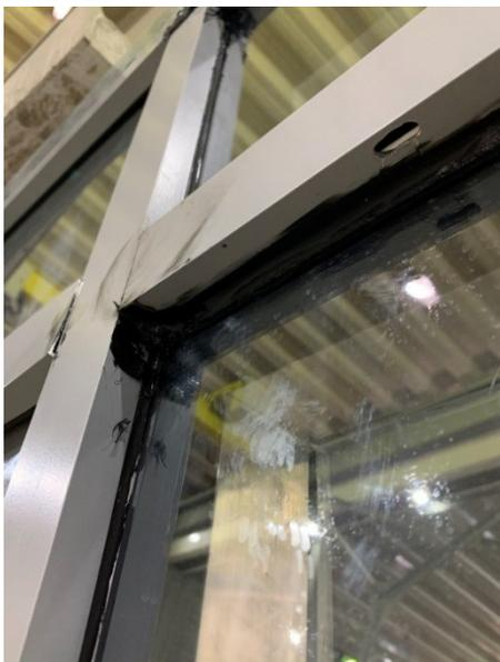
**Foto 9:** Selante no encontro da travessa intermediária superior com o montante da folha projetante deslizante (maxim-ar).
