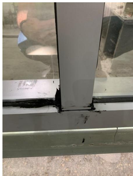
**Foto 6:** Selante no encontro da travessa inferior do marco com o montante nos vidros inferiores.
