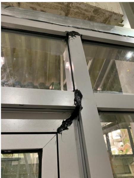
**Foto 3:** Selante no encontro: da travessa superior com o montante do vidro fixo superior e no encontro da travessa superior com o montante do marco da folha de girar e de tombar.
