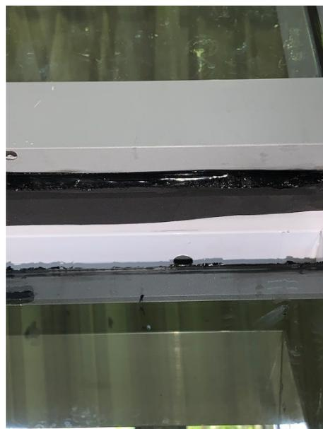
**Foto 12:** Fita de borracha aplicada na travessa superior da folha projetante deslizante (maxim-ar).
