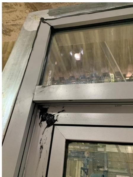
**Foto 2:** Selante aplicado: no encontro da travessa superior com o montante do marco e no encontro da travessa superior com o montante do marco da folha de girar e de tombar.
