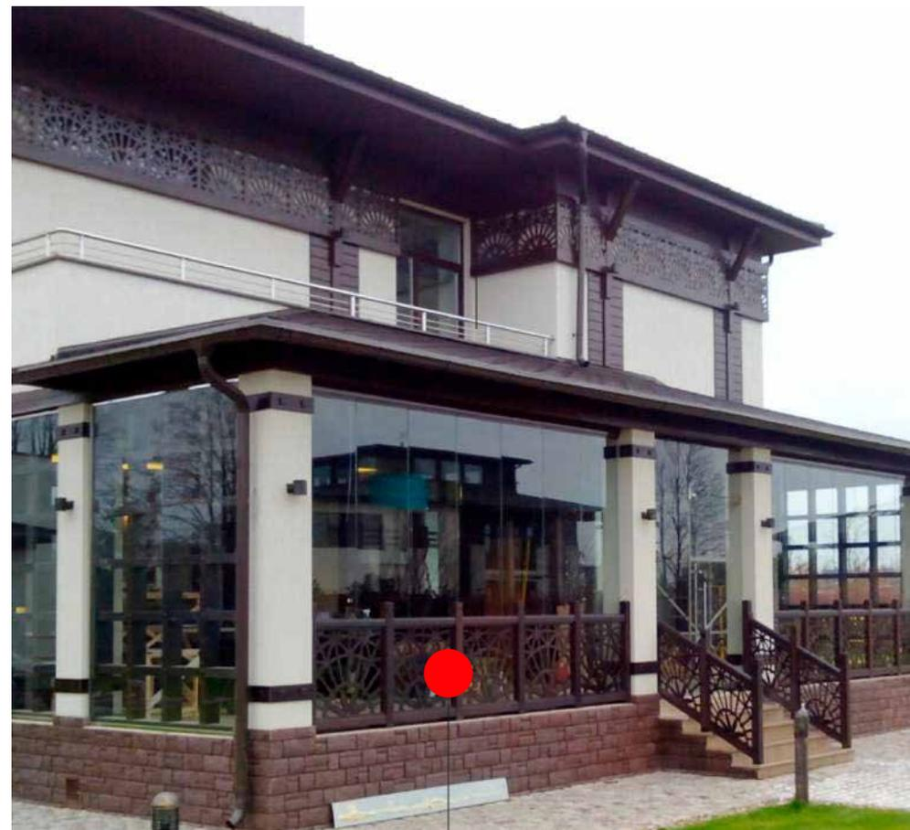
Dependendo da altura desejada da instalação, podem ser utilizados vidros temperados ou laminados com espessuras de **8, 10 ou 12 mm**.
